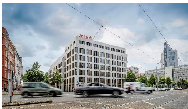
Das neue Headquarter liegt im Herzen Leipzigs. Foto: Eric Kemnitz | Unite
